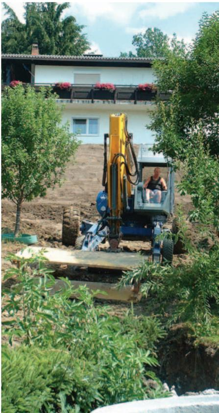
Eine sehr aufwendige Kanalsanierung mit Kosten in der Höhe von rund € 15.000,-- wurde im Bereich der Mühlreithsiedlung durchgeführt. Da bei der Errichtung, obwohl es ein sehr steiles Gelände ist, nur Polokalrohre verwendet wurden, wurde diese aufwendige Sanierungsmaßnahme notwendig. Bereits Ende Dezember 2002 ist dieser Schaden aufgetreten und konnte erst jetzt im Juni 2003
